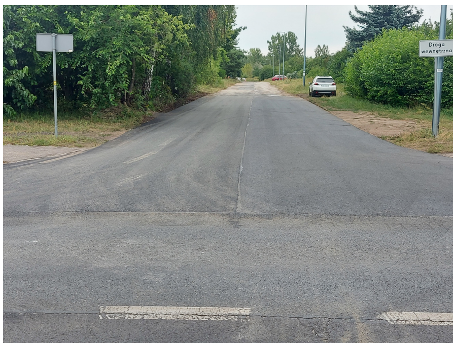
Rys 1. Wykonanie remontu ulicy w ramach projektu 334 z 2022 r.
