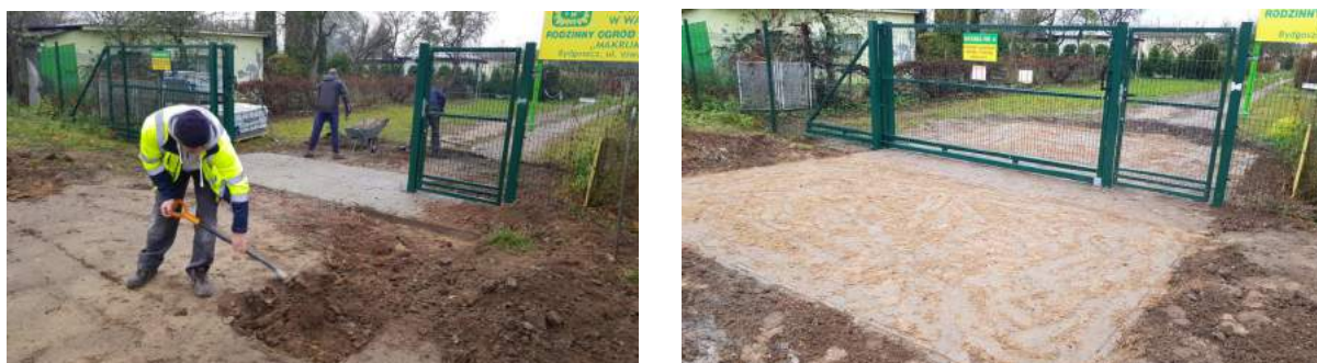
Rys. 16 Poszerzenie utwardzonego podjazdu przy bramie nr 4
