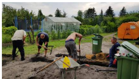
Rys. 19 Montaż monitoringu terenu ogólnego
