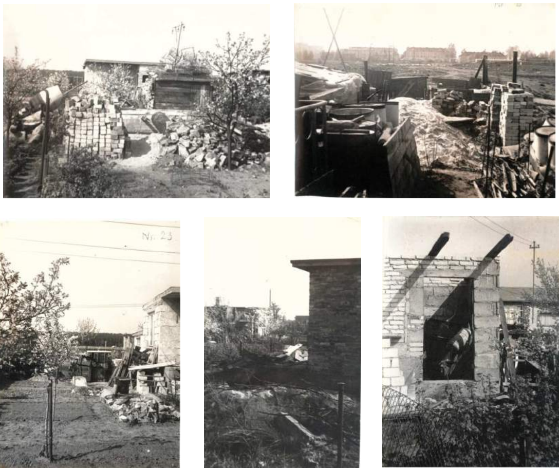
Rys. 2 Altany w trakcie budowy
