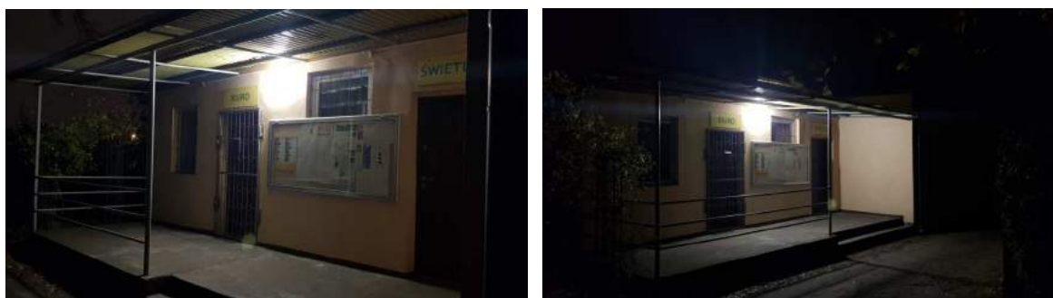
Rys. 17 Oświetlenie przy biurze
