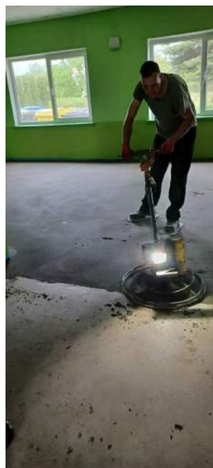
Rys. 29 Wylewka w pomieszczeniu nr 2
