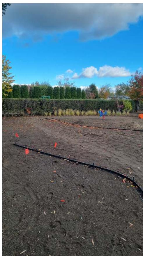
Rys. 12 Montaż obrzeży trawnikowych Ekoboard
