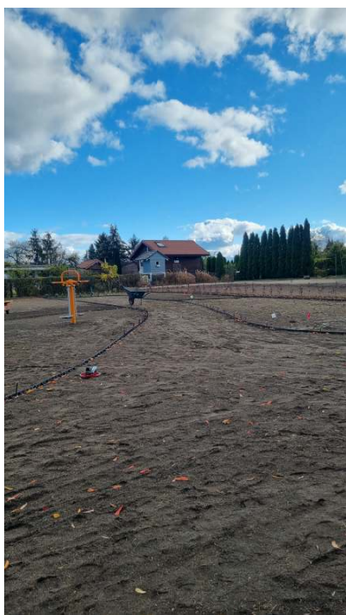
Rys. 12 Montaż obrzeży trawnikowych Ekoboard
